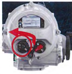
TA 06 (GV 8" & MOV 8") เลือกถังที่จะรับพร้อมเปิด Valve รับ 100 % ถึงที่ไม่ เกี่ยวข้อง ปิด Valve 100 %
