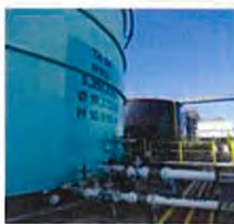
TA 06 (GV 8" & MOV 8") เลือกถังที่จะรับพร้อมเปิด Valve รับ 100 % ถึงที่ไม่ เกี่ยวข้อง ปิด Valve 100 %
